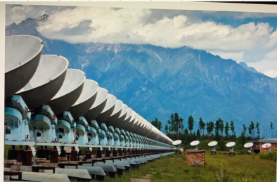
Сибирский солнечный радиотелескоп (ССРТ) — один из крупнейших астрономических инструментов, входящий в перечень уникальных установок России, нацеленный на перспективу радиотелескопической обсерватории «Большая телескопическая решетка» (БТР). ССРТ расположен в долине между хребтами Восточный Саян и Западный Саян в 200 км от Иркутска. Радиотелескоп представляет собой массивный радиотелескоп, состоящий из двух линий радиотелескопов длиной по 128 м каждая. Антенны имеют диаметр 2,5 м и установлены на равном расстоянии в 4,9 м друг от друга. На момент создания ССРТ (1988) он не имел мировых аналогов. Радиотелескоп предназначен для изучения солнечной атмосферы в радиодиапазоне длин волн 0,7 (ГГц). Наблюдения дают важную информацию как о солнечных активных областях, происходящих в них вспышках, выбросах корональной массы, так и сведения о ионосферных областях на Солнце, тропе или коронарных дырах, ярком корональном тоне, коронах.
